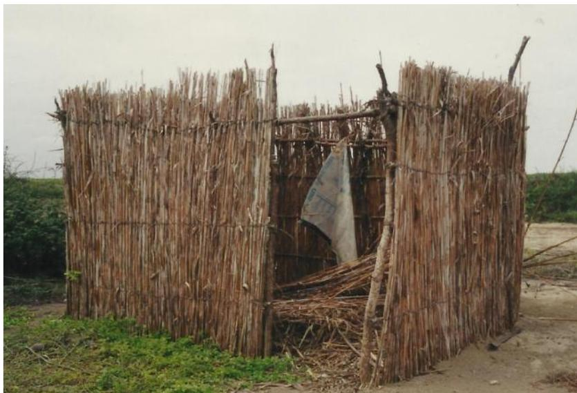
Figura 13. Vivienda rústica de quincha sin enlucir (en proceso de construcción), en la zona agrícola del valle de Chicama.
